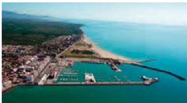
El port de Borriana. En primer terme, l'escullera de Garbí i, tancant la Bocana, l'escullera de Llevant. La construcció del port va alterar la línia de costa, ja que la mar se'n va entrar a ponent i es va retirar a llevant, fet que originà la superfície de l'Arenal. Al fons, a l'esquerra de la fotografia, el perfil del cap Gros, les Agulles i el coll de la Vaca.
