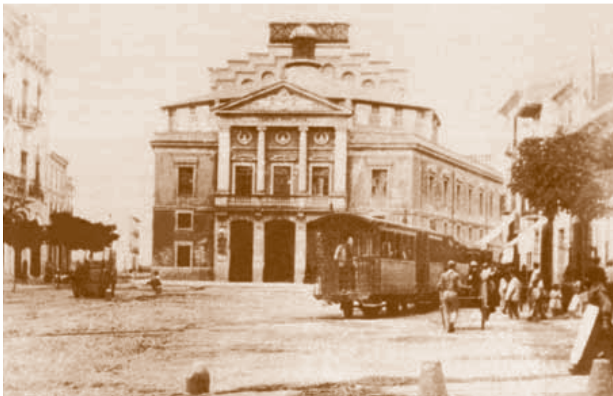
Teatre Principal de Castelló de la Plana, primer terç del segle XX
